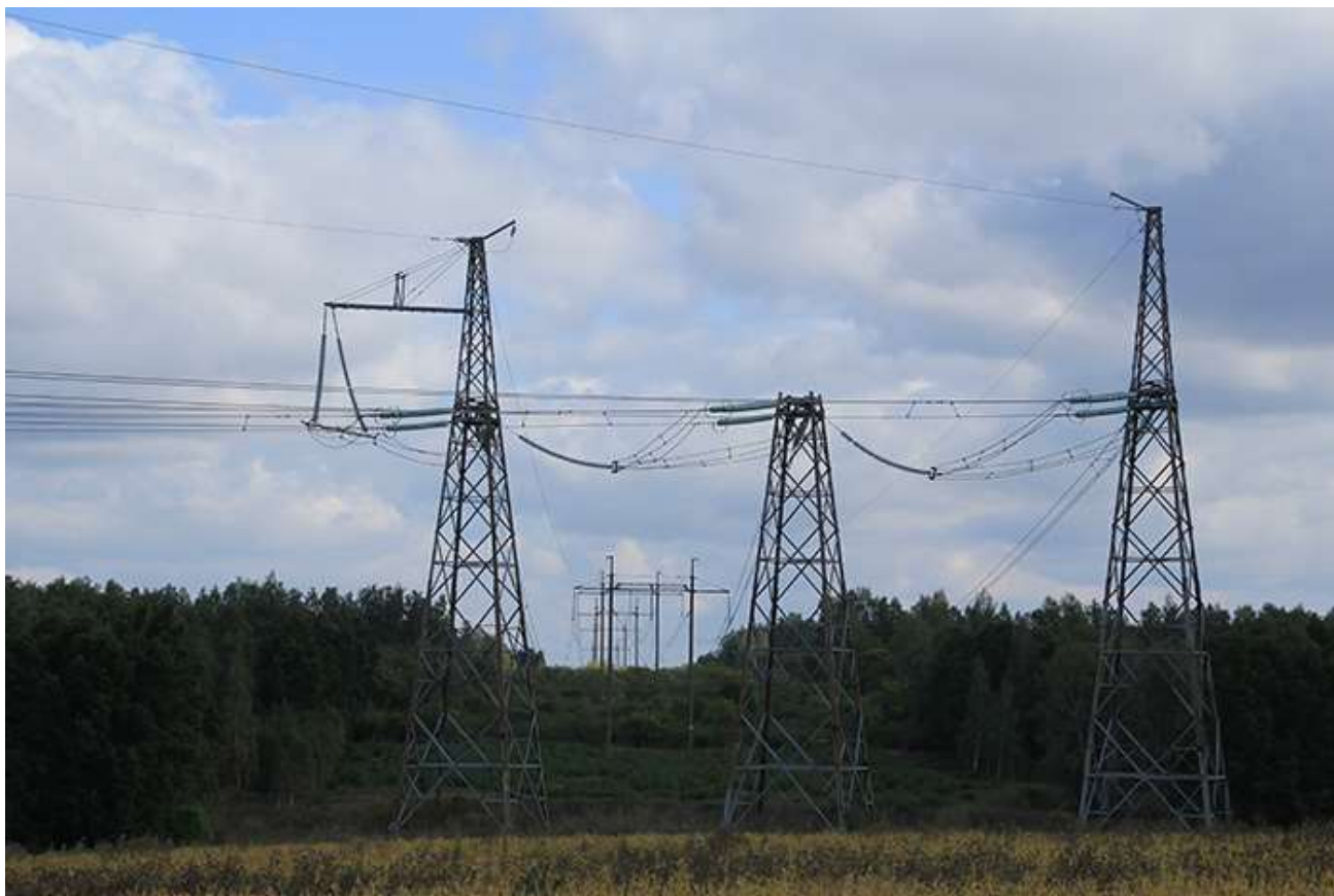
Рис. 5.21. Обратите внимание на малозаметный провод молниеотвода на вершинах опор ЛЭП.
